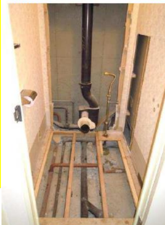
【他物件参考写真】トイレ壁床開口
