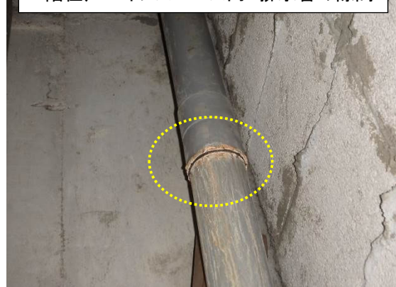
6階住戸パイプスペース内 排水管の隙間
